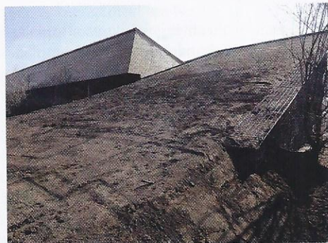
Het weiland loopt letterlijk over in het dak van de ontvangstruimte. Het dak wordt ingezaaid met een bloemrijk graslandmengsel.
